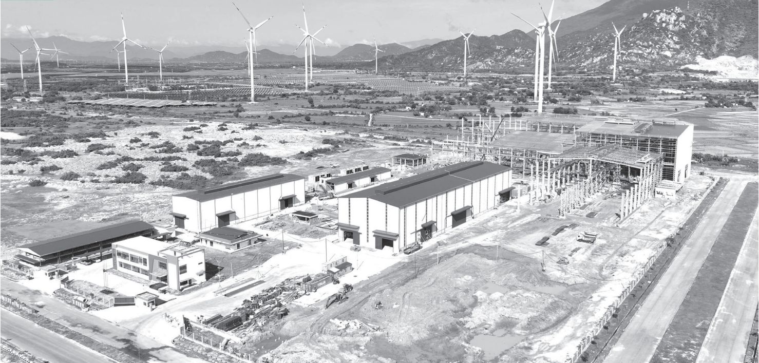
● Một dự án công nghiệp đang trong quá trình hoàn thiện xây dựng tại Khu Công nghiệp Du Long.
