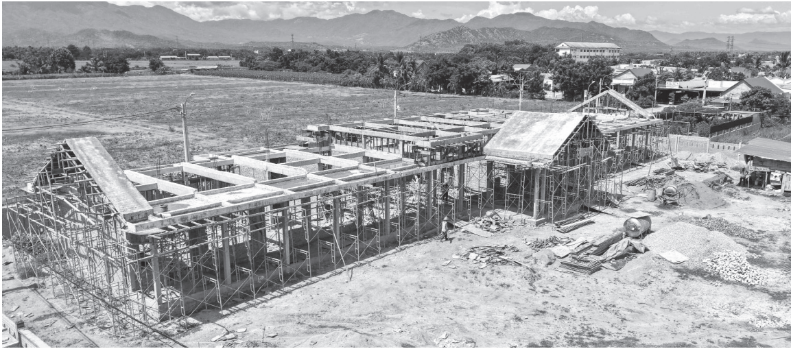
Công trình Trường Mầm non Nha Hồ được đẩy nhanh thi công.
