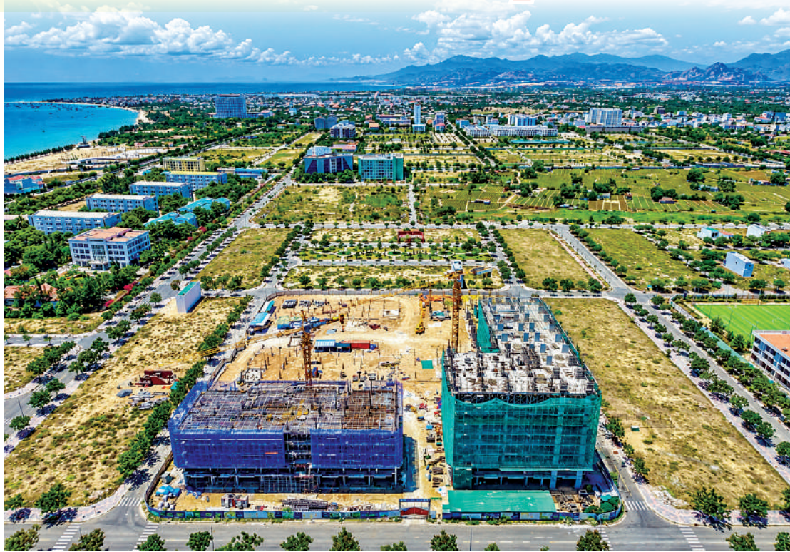
● Thi công nhà ở xã hội tại Khu đô thị biển Bình Sơn - Ninh Chữ (Khu K2, phường Đông Hải). Ảnh: M.HÙNG
