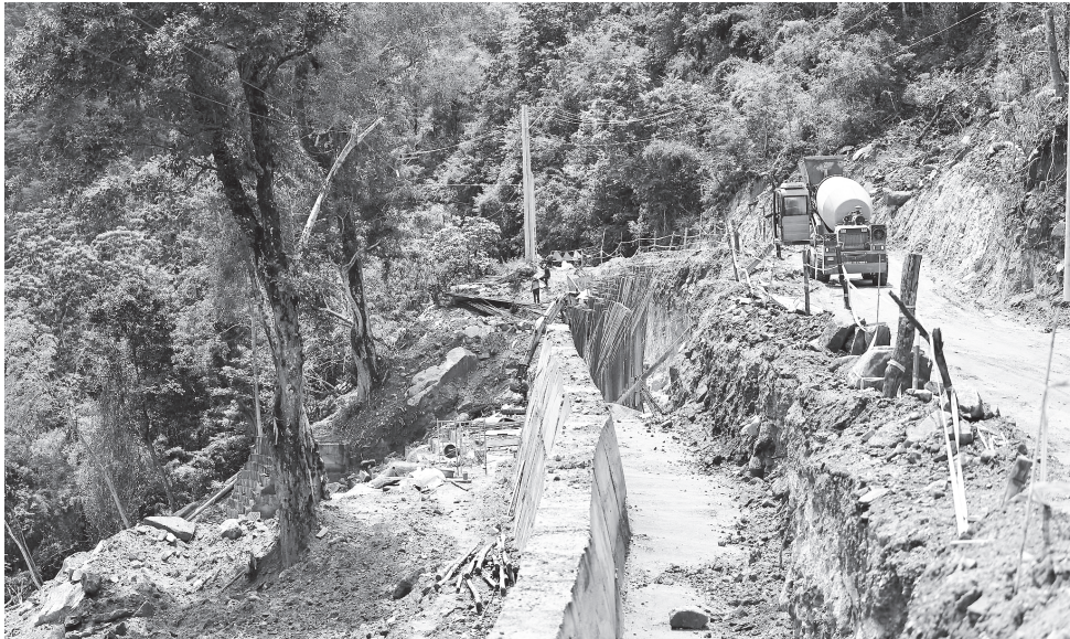
● Công trình gia cố, khắc phục sạt lở đất đá tuyến Tỉnh lộ 707 qua xã Bác Ái Tây đang triển khai thi công.
