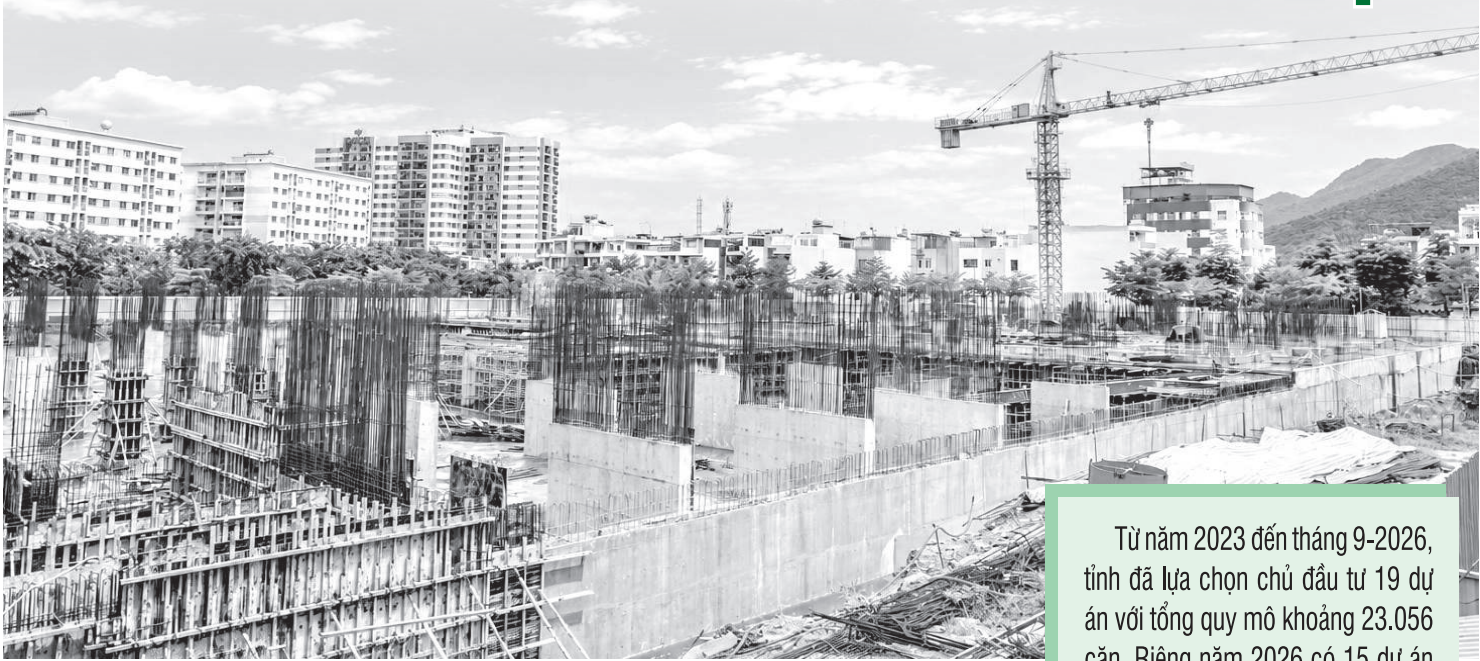
● Thi công Nhà ở xã hội CT-01 (phường Nam Nha Trang).
