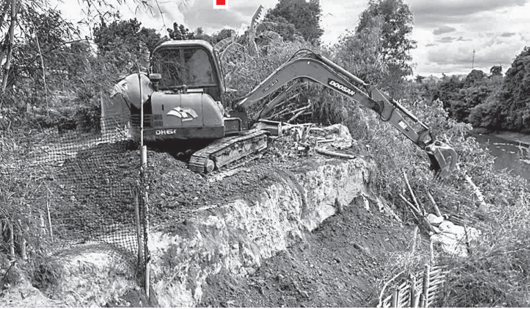
• Phương tiện cơ giới được huy động thực hiện công tác gia cố bờ sông Tân Lâm.
