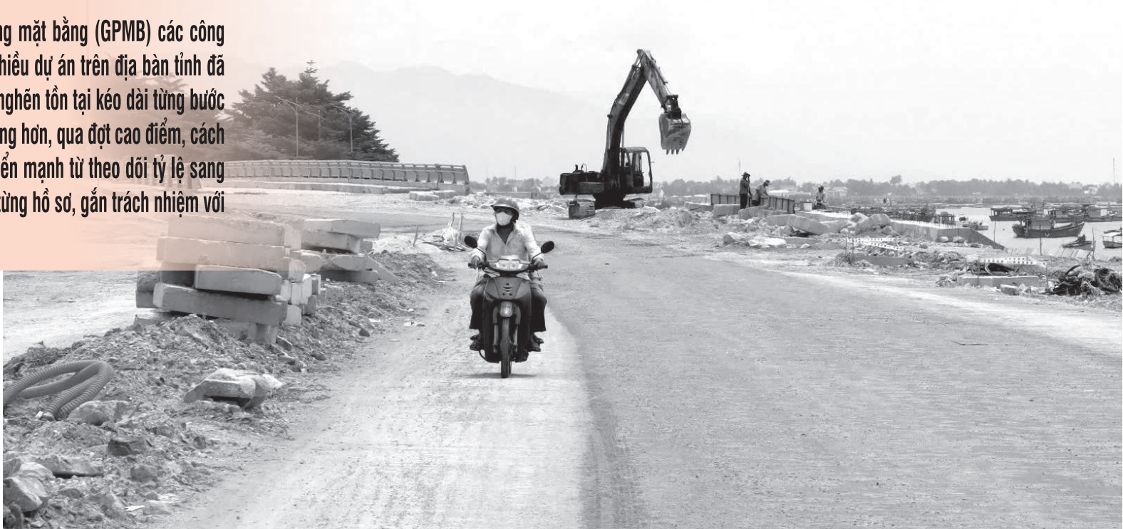
Thi công tại Dự án đường ven biển nối Vạn Ninh - Ninh Hòa.
