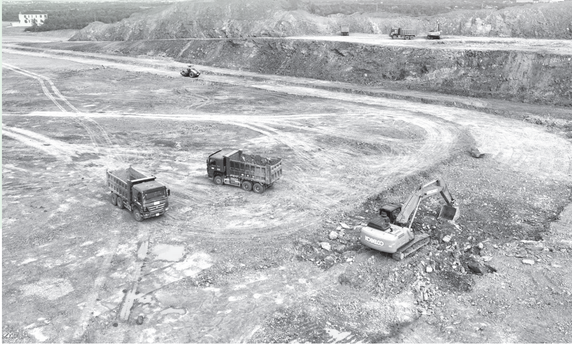
● Dự án Khu công nghiệp Đốc Đá Trắng tháo gỡ vướng mắc mặt bằng, đẩy nhanh tiến độ thi công.
