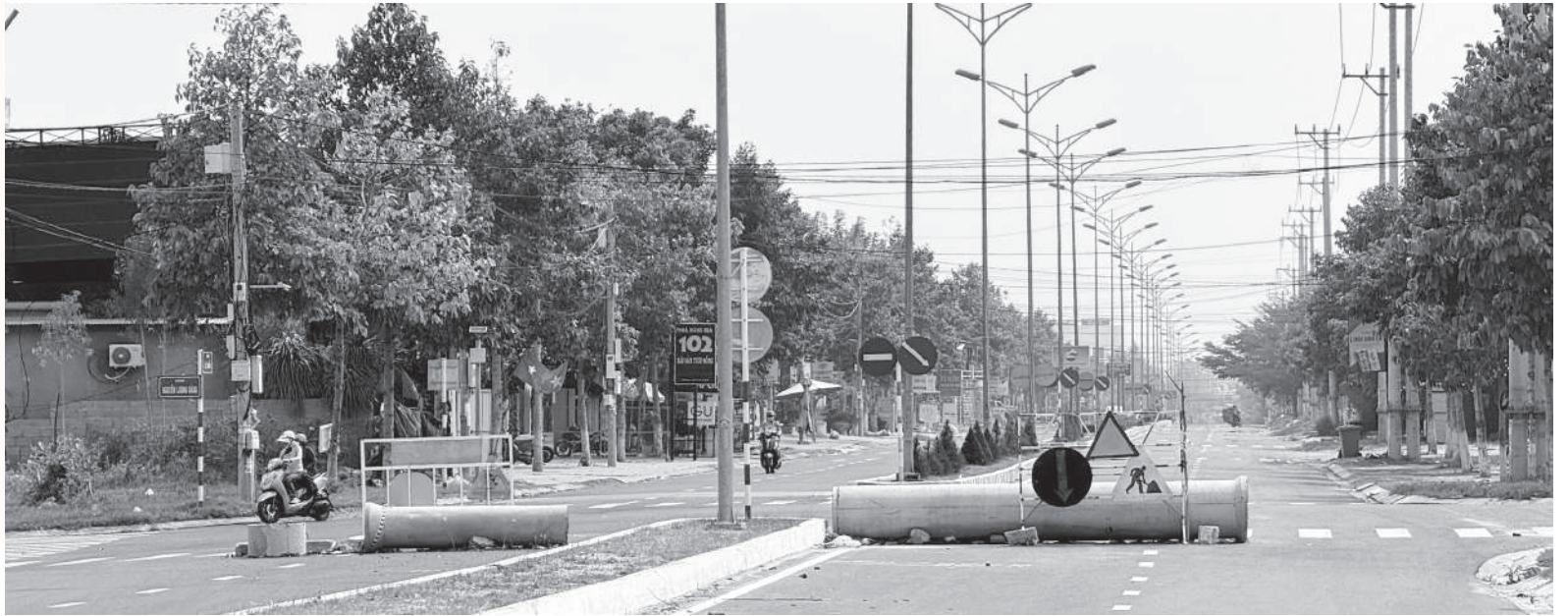
● Đoạn đầu dự án tiếp giáp với đường Lê Duẩn - đoạn 2 và giao với đường Nguyễn Lương Bằng được chặn bằng những khối bê tông để hạn chế phương tiện giao thông đi vào.
