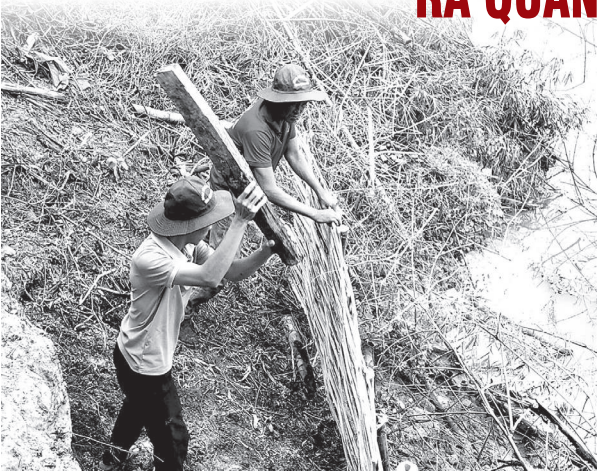
● Những tấm liếp được đóng tại các vị trí tạo chân giữ, hạn chế sạt lở tiếp diễn.
