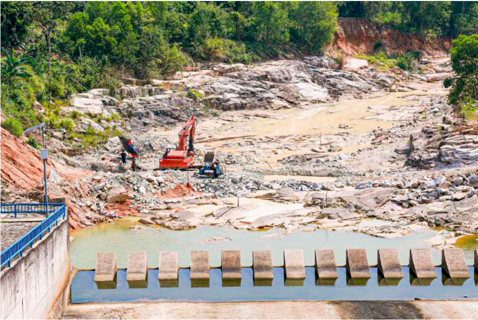
● Thi công đường ống dẫn nước Sông Chò 1 nối với hồ Suối Dầu.
