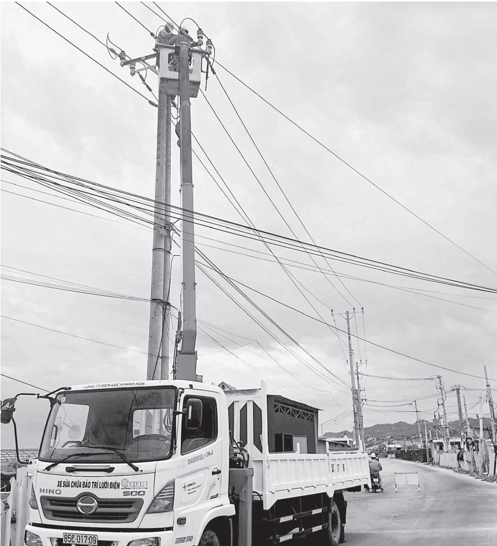
● Công nhân Công ty Điện lực Khánh Hòa thi công, bảo trì lưới điện để bảo đảm vận hành an toàn trong mùa mưa bão.
