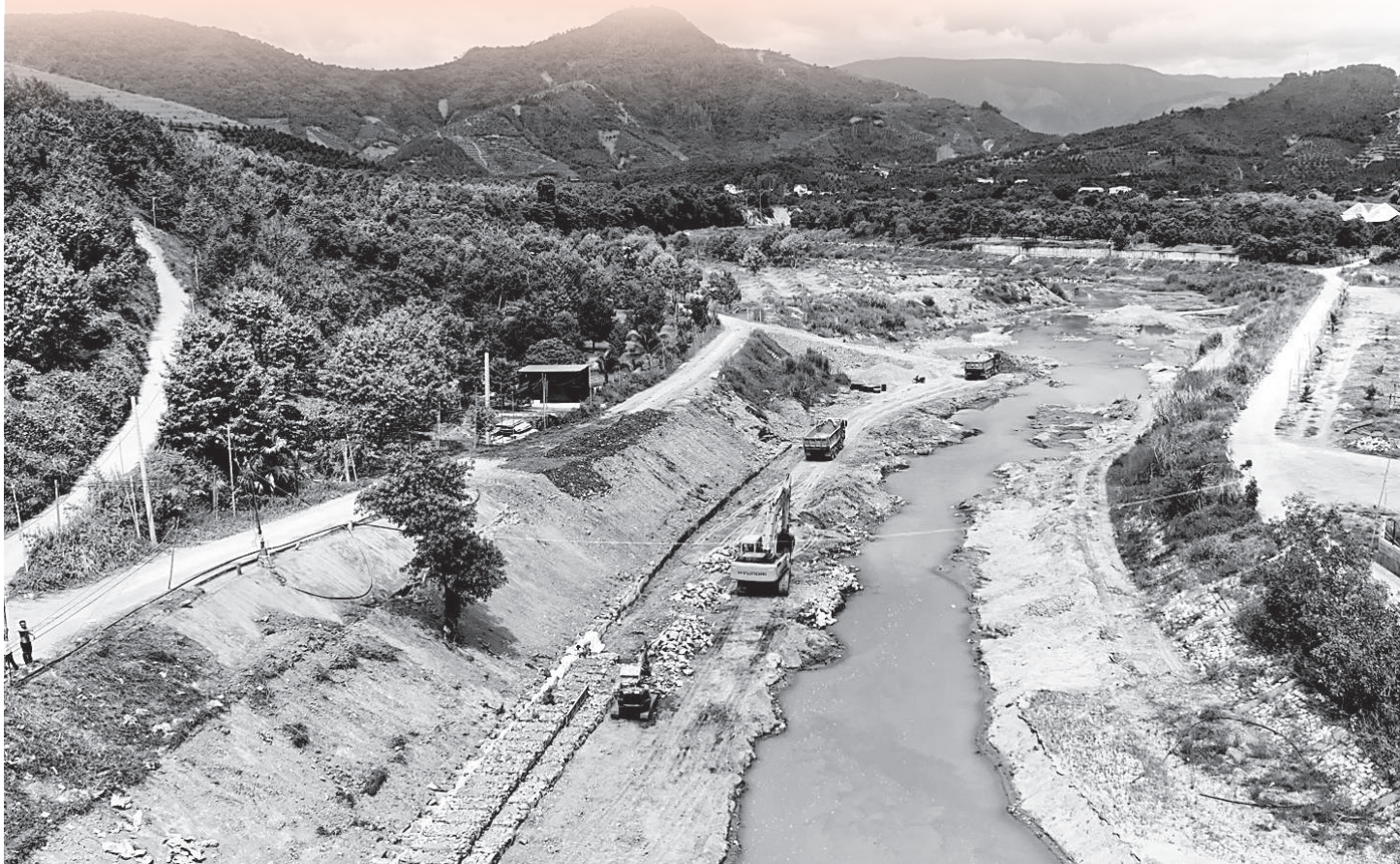
● Gia cố mái taluy kè sông Tô Hạp, thuộc Dự án Đường số 18, thôn Cam Khánh.
