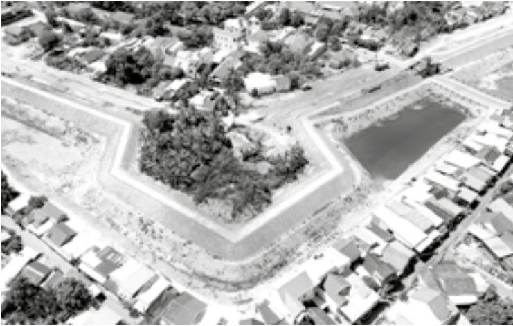
● Một góc phía tây Thành cổ Diên Khánh đang được tổ chức thi công.
