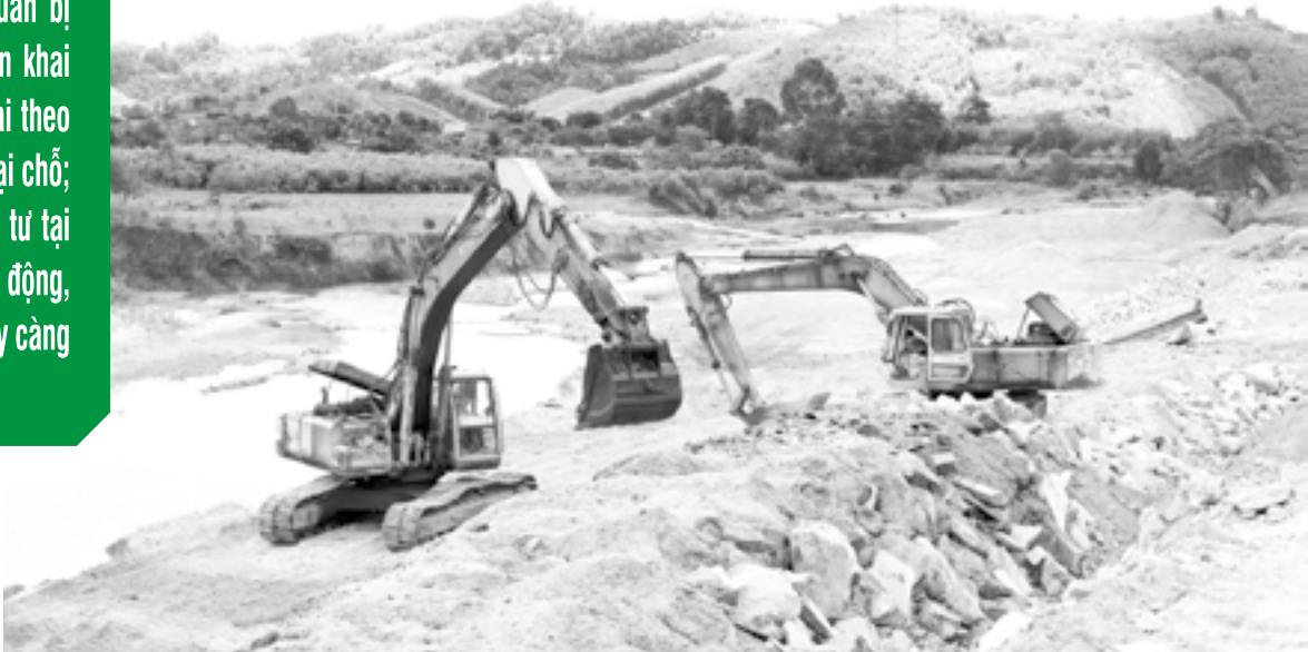
● Công trình phòng, chống lũ lụt tại xã Tây Khánh Vĩnh đang được gấp rút hoàn thành.
