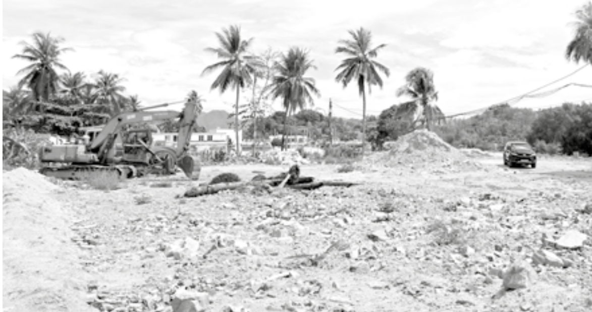
● Phần mặt bằng được bàn giao đã được nhà thầu san ủi, chuẩn bị đường công vụ thi công.
