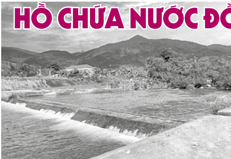
● Đập dâng Vinh Huê (xã Vạn Ninh) thuộc khu vực triển khai Dự án Hồ chứa nước Đồng Điện.
