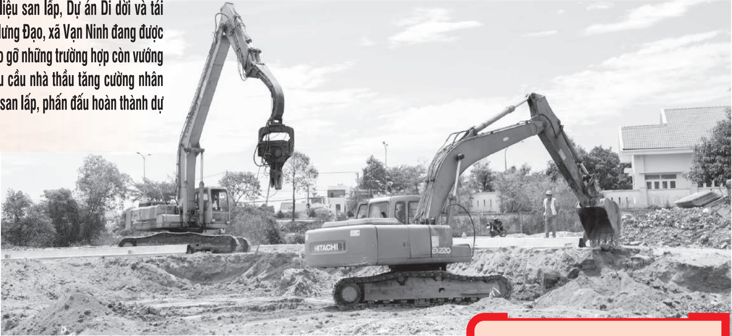
● Dự án đang được đẩy nhanh tiến độ thi công.
