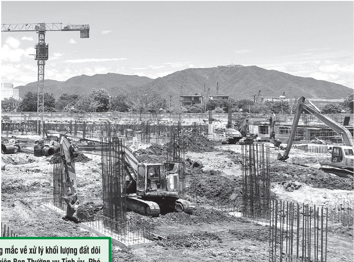
● Một dự án nhà ở xã hội ở Khu đô thị An Bình Tân (phường Nam Nha Trang) đang thi công.
