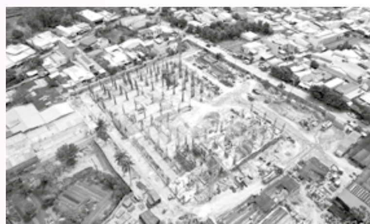
● Dự án Nhà ở xã hội Vinh Hải đang được triển khai thi công.
