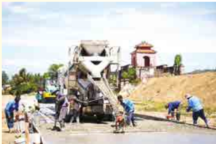
● Công nhân thi công hạng mục công trình tu bổ, tôn tạo Thành cổ Diên Khánh.
