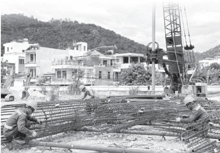
● Dự án Nhà ở xã hội Hưng Phú II, phường Bắc Nha Trang đang được đẩy nhanh tiến độ thi công.
