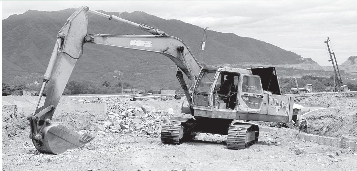
● Khu vực công trình chỉnh trị hạ lưu Sông Tắc (Giai đoạn II) tại phường Nam Nha Trang. Ảnh: THÁI THỊNH
