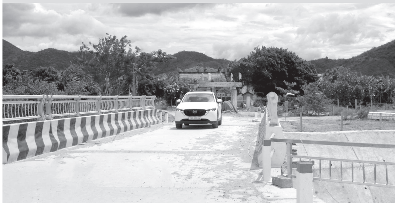
● Công trình cầu số 3 thôn Tân Hiệp vừa hoàn thành đưa vào sử dụng.
