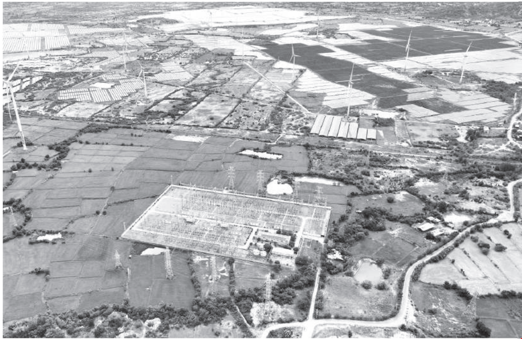
● Trạm biến áp 220kV Tháp Chàm được sửa chữa, nâng cấp để giải phóng hết công suất các nhà máy điện năng lượng tái tạo trong khu vực.
