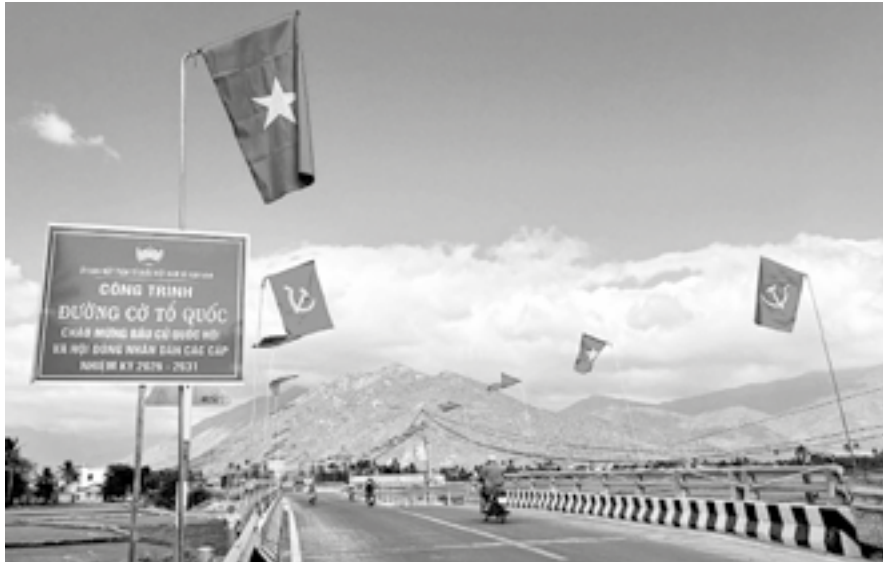
● Nhiều tuyến đường ở xã Vạn Ninh được đầu tư xây mới, trang hoàng cờ Tổ quốc rực rỡ.
