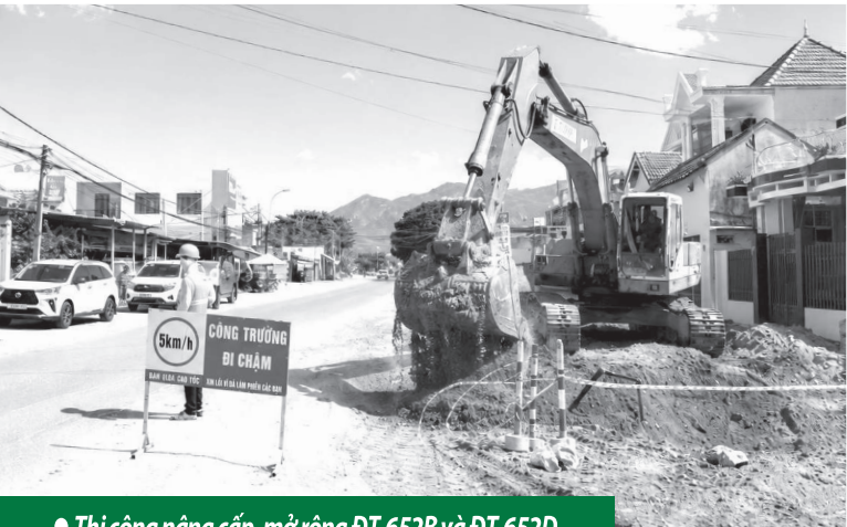
● Thi công nâng cấp, mở rộng ĐT.652B và ĐT.652D.
