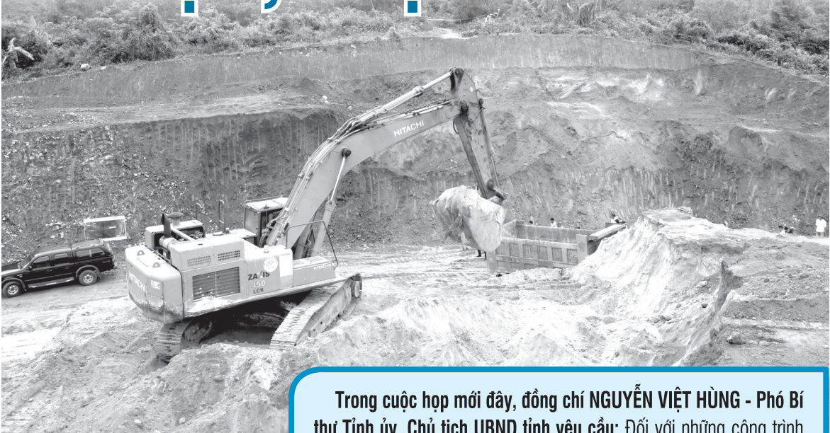
● Công trường Dự án Đường giao thông liên vùng Khánh Sơn - Khánh Vĩnh.
