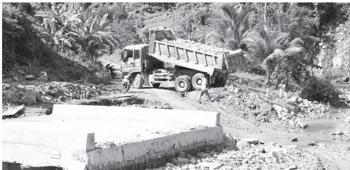
● Công trình cống thoát nước qua suối tại đường dẫn từ khu tái định cư vào khu sản xuất xóm 4 thôn Dốc Trầu được thi công.
