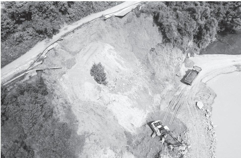
● Thi công khắc phục sạt lở trên tuyến đường Hòn Dung - Tà Gụ.
