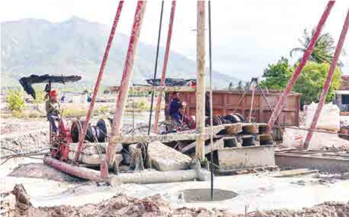
● Thi công mở cầu Đùi trên tuyến đường ĐT.652B.
