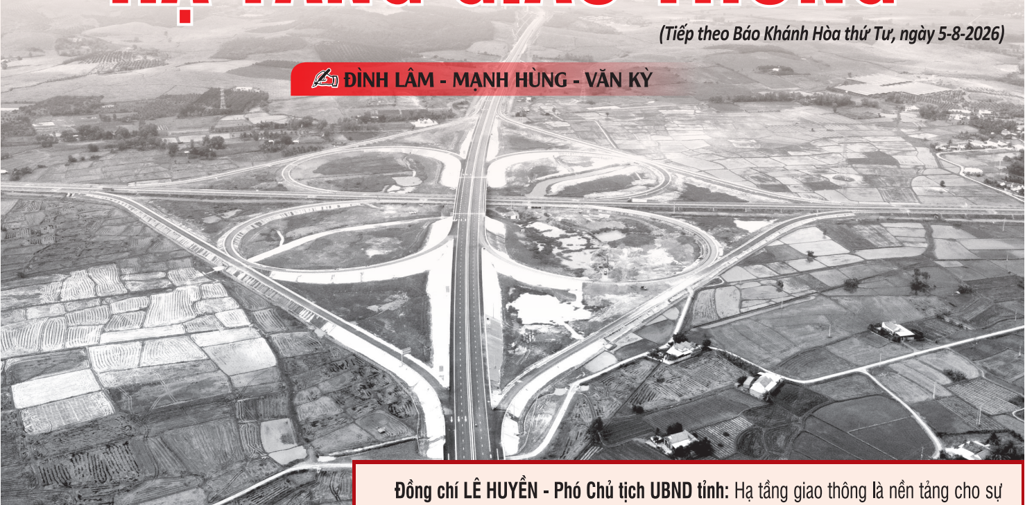
● Dự án Đường bộ cao tốc Khánh Hòa - Buôn Ma Thuột đã hoàn thành 20km đầu tuyến.
