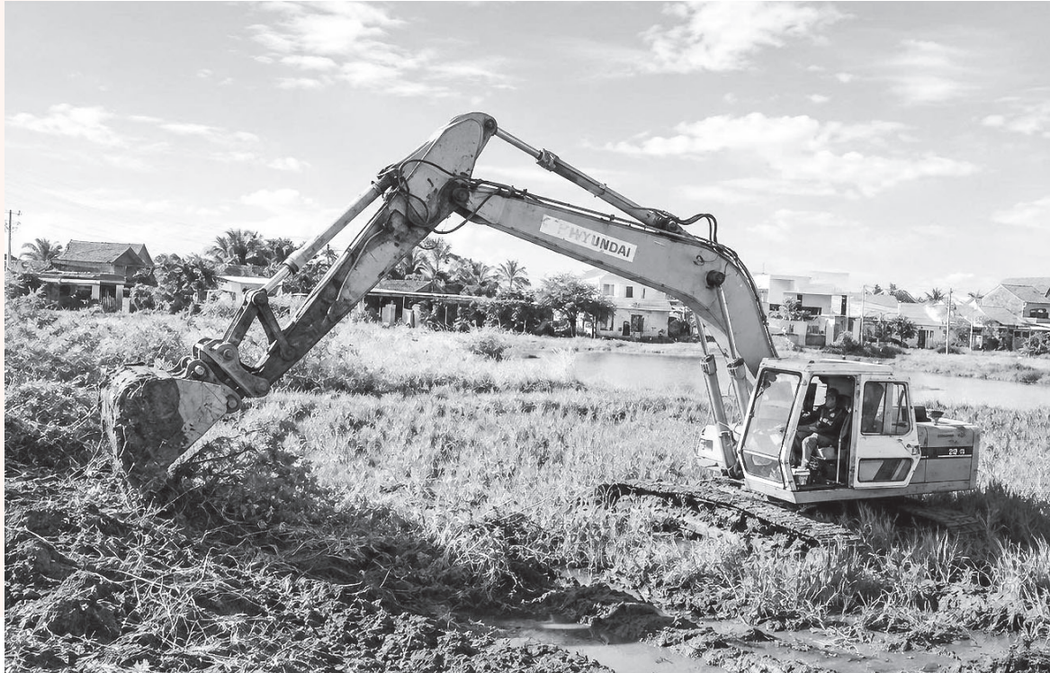
● Dự án Khu tái định cư Tân Định đã hoàn thành giải phóng mặt bằng, bắt đầu triển khai thi công.
