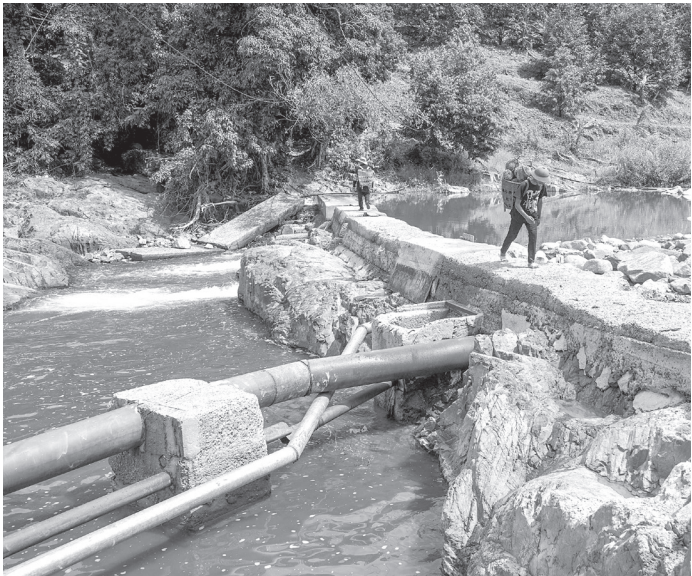
● Đập dâng đầu nguồn hệ thống cấp nước Sơn Lâm đã được sửa chữa.
