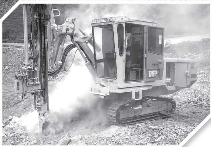
● Công nhân thi công trên đèo Khánh Sơn.
