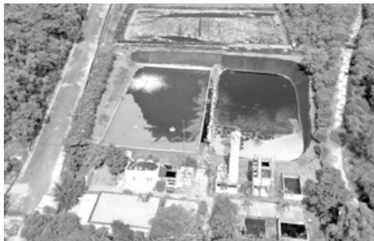
● Khu vực Trạm xử lý nước rỉ rác Lương Hòa (phường Bắc Nha Trang).
