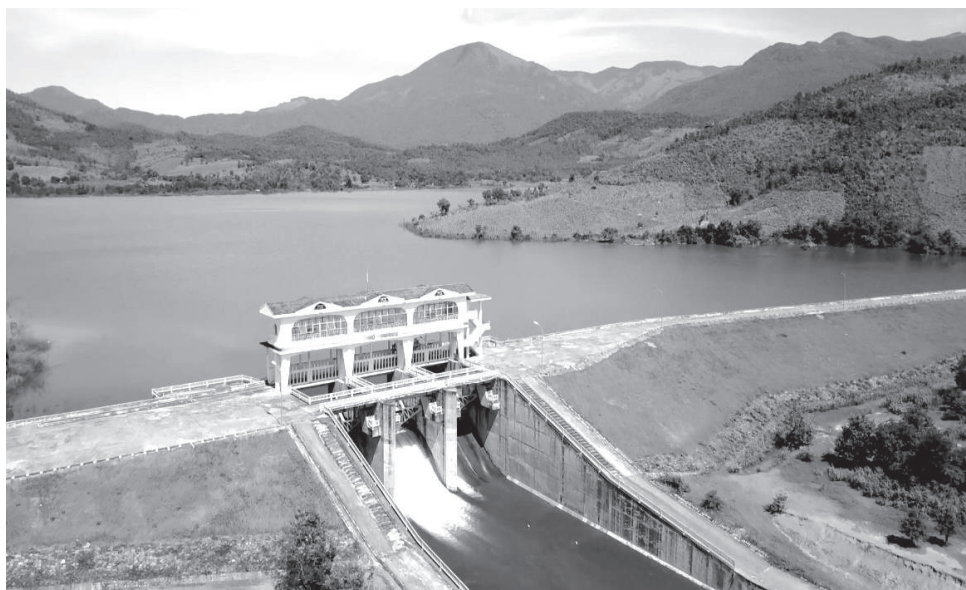
● Hồ Trà Co (xã Bắc Ái) là một trong những công trình đã được lắp đặt hệ thống quan trắc khí tượng thủy văn và giám sát khai thác tài nguyên nước.
