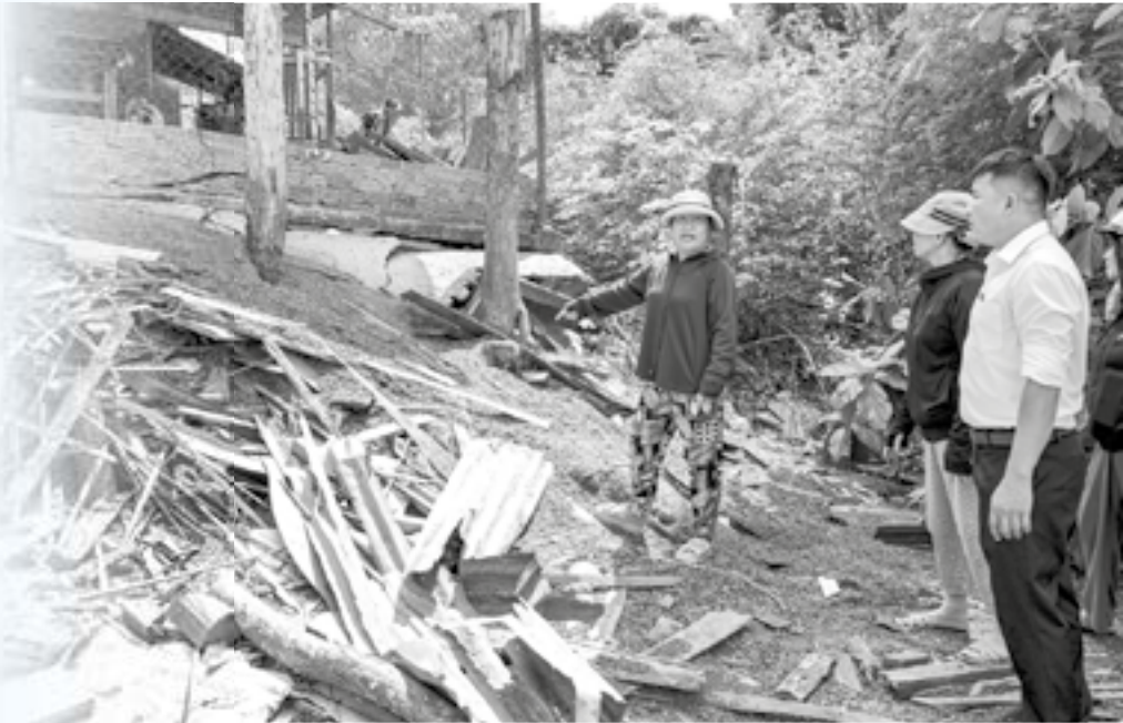
● Khu vực sạt lở phía sau nhà bà Chế Thị Lưu được gia đình gia cố tạm bằng mùn cưa và xà bần để hạn chế đất tiếp tục bị cuốn trôi.
