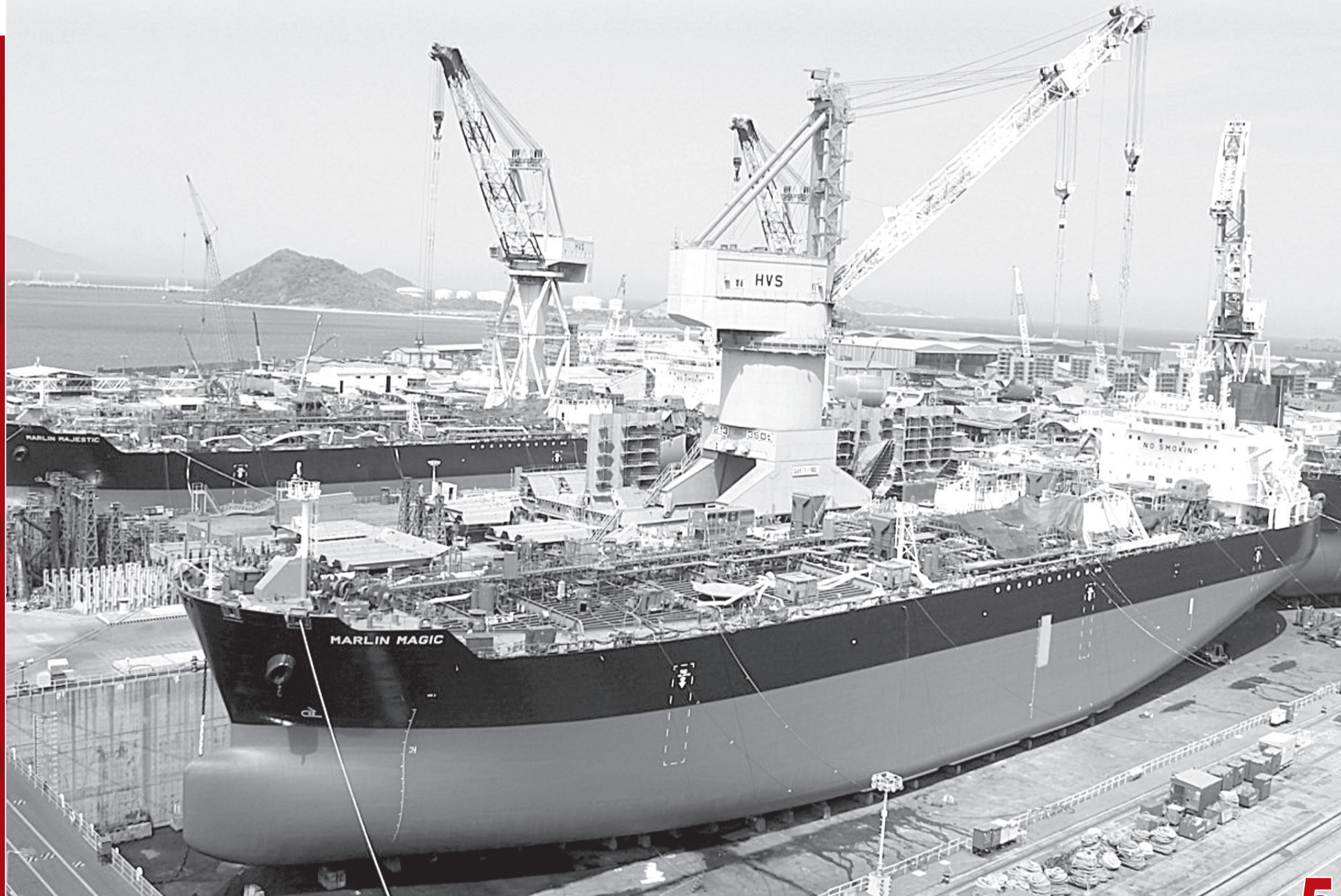
• Một con tàu đang trong quá trình hoàn thiện các hạng mục để hạ thủy tại Công ty TNHH Đóng tàu HD Hyundai Việt Nam.
