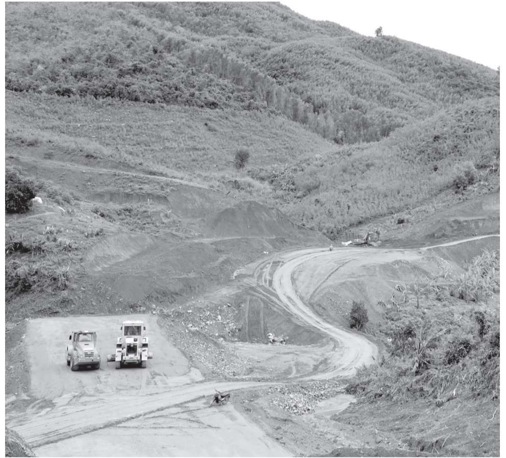
● Công trường Dự án Đường liên vùng Khánh Sơn - Khánh Vĩnh.
