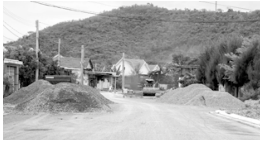
● Dự án đường Minh Mạng đang đẩy nhanh tiến độ.
