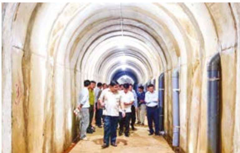
● Phó Chủ tịch UBND tỉnh Trịnh Minh Hoàng kiểm tra hành lang kiểm tra đập thuộc công trình hồ chứa nước Sông Than, xã Anh Dũng.
