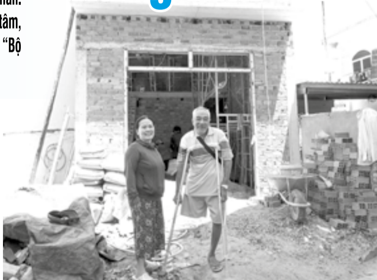
● Vợ chồng ông Lê Đình Phùng vui mừng bên căn nhà đang dần hoàn thiện.
