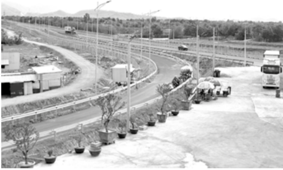
● Dự án Đường nối từ đường bộ cao tốc Bắc - Nam với Quốc lộ 1 và Cảng biển tổng hợp Cà Ná.
