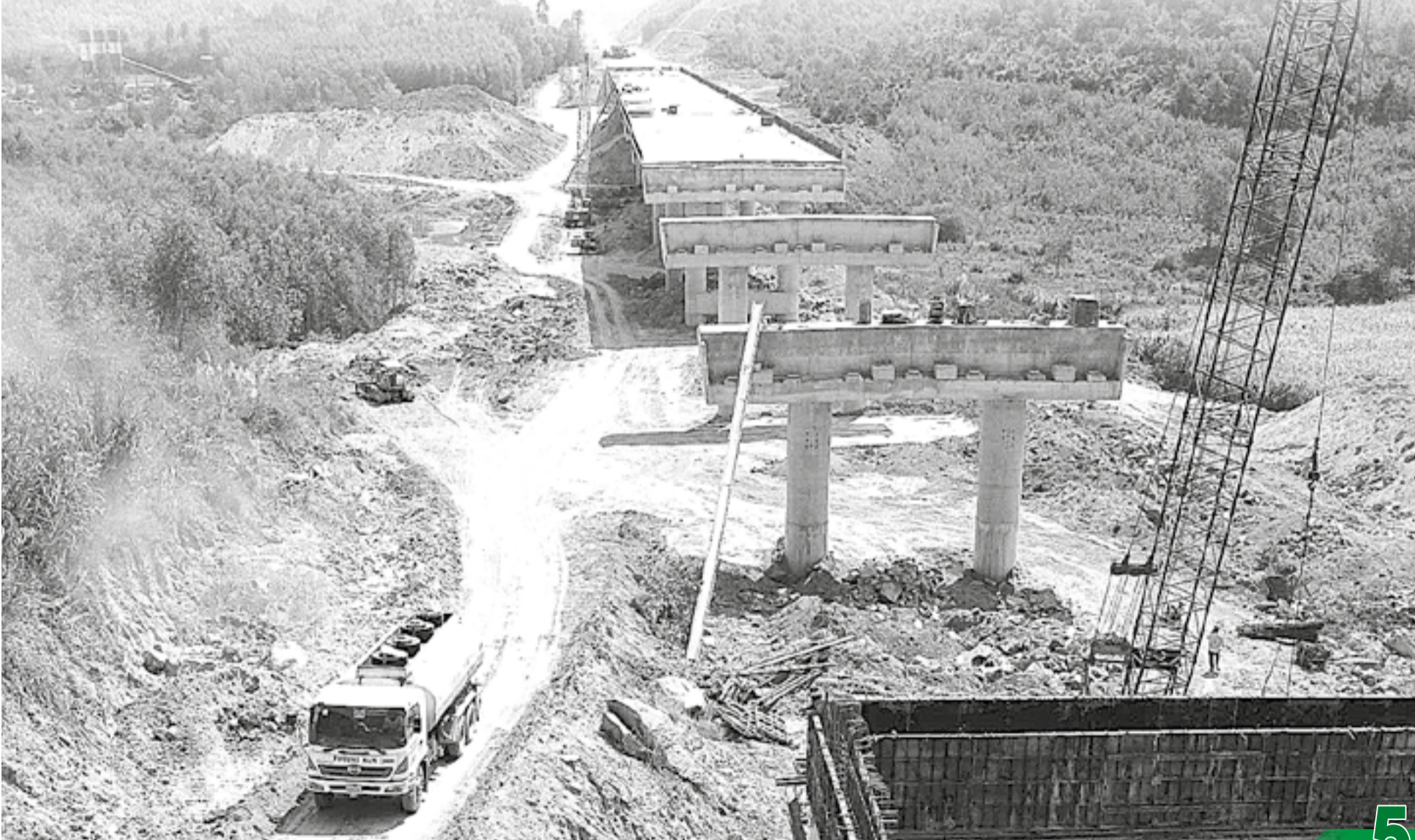
• Thi công đường bộ cao tốc Khánh Hòa - Buôn Ma Thuật.
