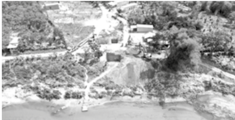
● Cầu treo bị gãy đổ sau mưa lũ ở xã Nam Khánh Vinh đang được thi công xây mới.
