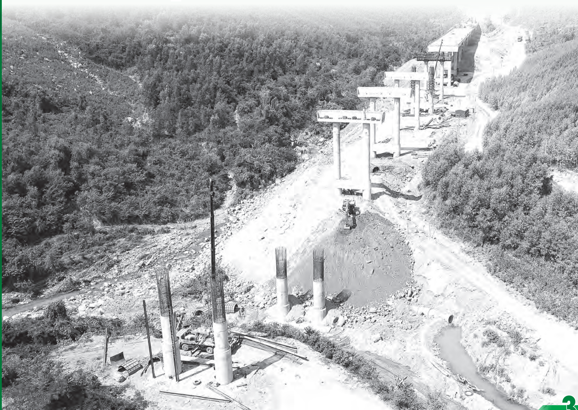
• Công trường Dự án Đường bộ cao tốc Khánh Hòa - Buôn Ma Thuột.
