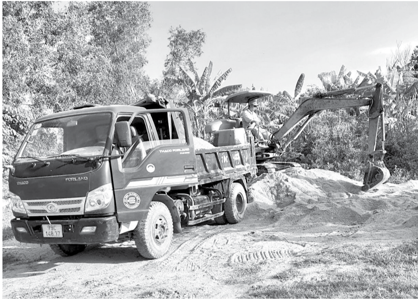
● Lực lượng chức năng phường Tây Nha Trang kiểm tra, xử lý điểm tập kết cát trái phép. (ảnh do địa phương cung cấp)
