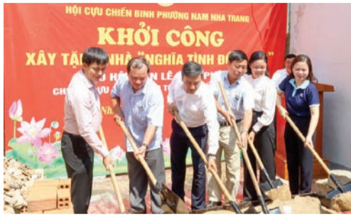
● Các đại biểu thực hiện nghi thức động thổ xây dựng nhà.
