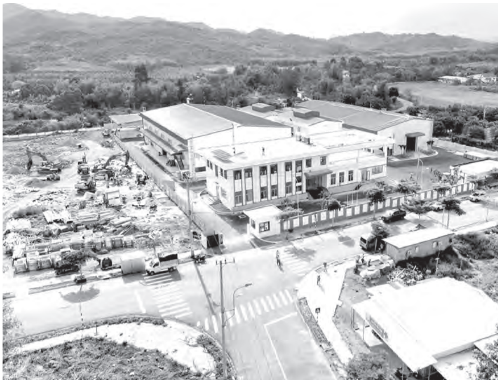
● Một nhà đầu tư thứ cấp đang hoàn thiện nhà xưởng tại Cụm Công nghiệp Sông Cầu.
