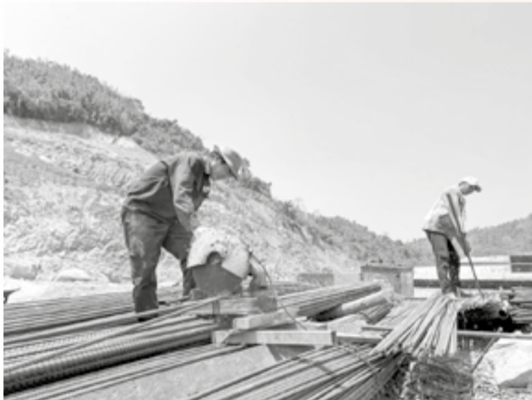
● Công nhân Tổng Công ty Xây dựng Trường Sơn thi công trên công trường giáp địa phận tỉnh Đắk Lắk.
