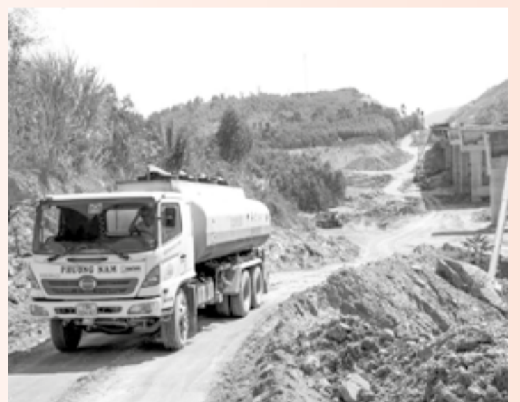
● Xe chở dầu vẫn miệt mài vận chuyển phục vụ công trình.
