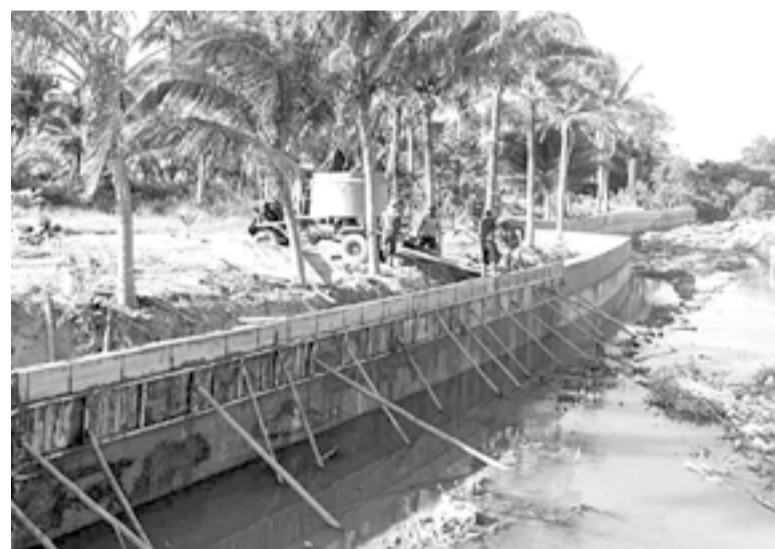
● Hàng mục kè thuộc Dự án Đường vào khu sản xuất Đồng Gốc, thôn Hiệp Mỹ đang được hoàn thiện.
