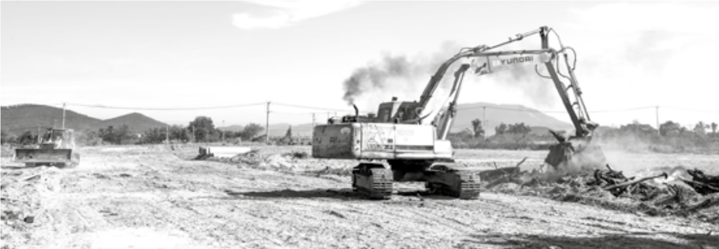
Thi công tại Dự án Khu tái định cư Vạn Thắng.
