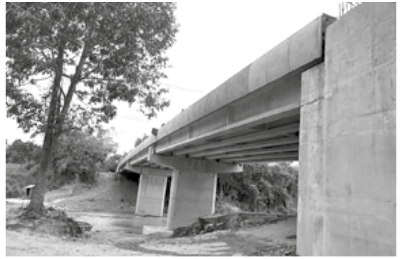
● Cầu Sông Chò đã cơ bản hoàn thành, nhưng chưa có mặt bằng để làm đường dẫn 2 đầu cầu.
