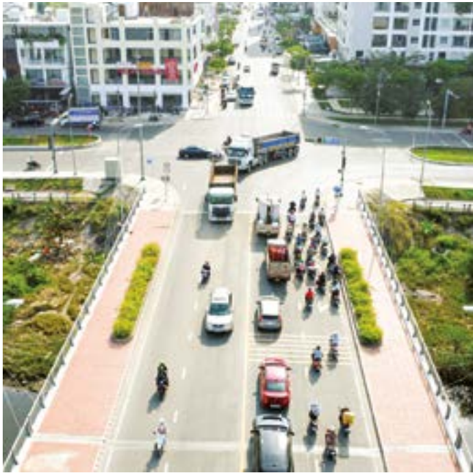
● Việc dừng xe chờ đèn đỏ quá lâu trên cầu Quán Trường ảnh hưởng đến kết cấu, tuổi thọ thiết kế của công trình cầu.
