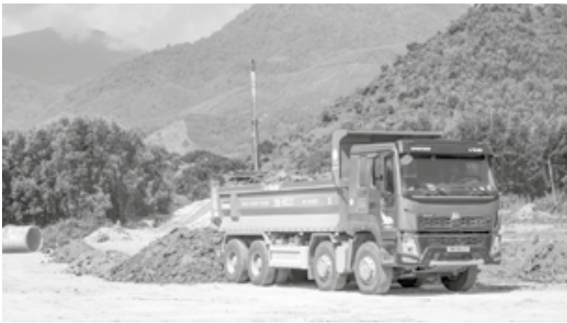
● Công trường đường giao thông liên vùng Khánh Sơn - Khánh Vĩnh đoạn qua xã Khánh Vĩnh.
