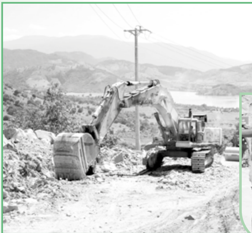
● Thi công tuyến đường vào công trình.
