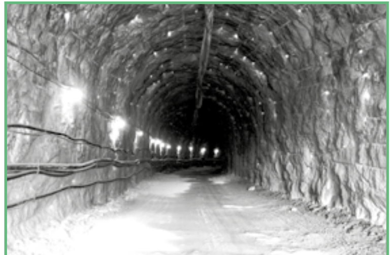
● Bên trong đường hầm đào sâu trong lòng núi.
