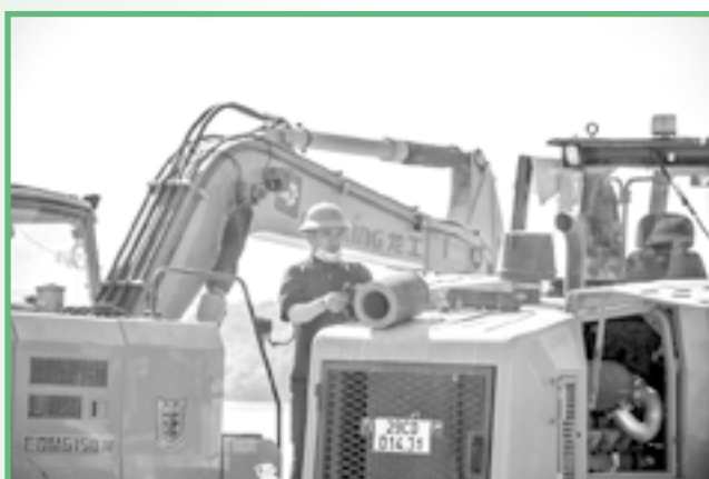
● Nhân viên kiểm tra bảo trì máy móc thiết bị để phục vụ thi công công trình.
