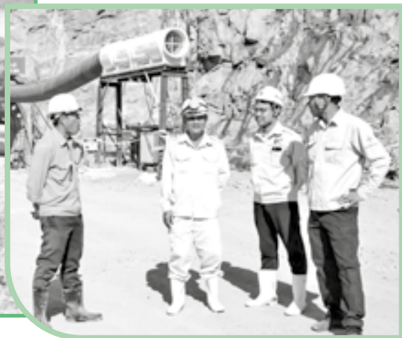
● Các kỹ sư, công nhân Tổng Công ty Xây dựng Lũng Lô (Bộ Quốc phòng) trao đổi công việc trên công trường.
