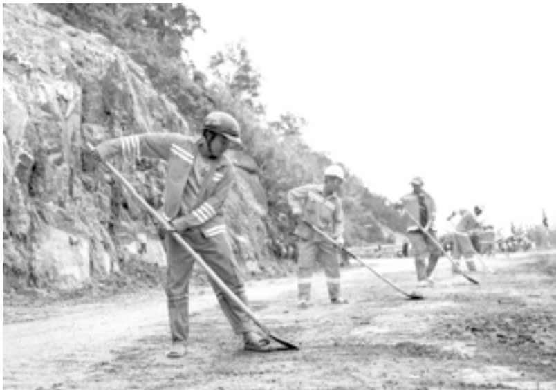
● Công nhân Công ty Cổ phần Quản lý và Xây dựng đường bộ Khánh Hòa thu dọn mặt đường tại Km40 (xã Nam Khánh Vĩnh).
