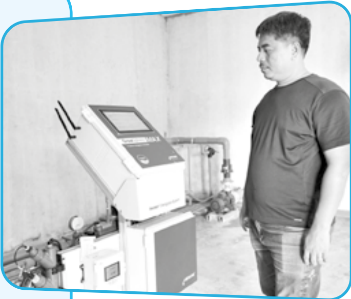
● Chapor Farm ứng dụng bộ điều khiển tưới, bón phân tự động GrowSphere của Netafim (Israel).
