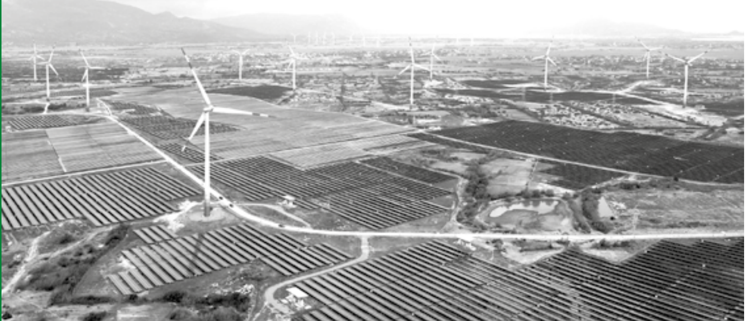
● Trang trại điện gió và điện mặt trời Trung Nam.
